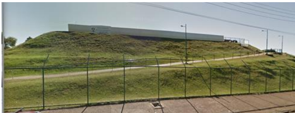
Figura 5 – Fachada da EMEF Cristo Rei CAIC
