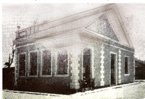
FIGURA 4 – ESCOLA ISOLADA DE ROÇADO – JOINVILLE/SC
