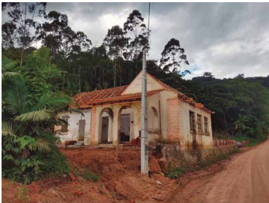
Figura 1. Escola Isolada Mulde Central fundada em 1949, em Timbó, Santa Catarina. Fonte: Disponível em < https://www.timbo.sc.gov.br/fundacao-de-cultura-e-turismo/2020/escola-isolada-mulde-central-e-restaurada-para-uso-publico-e-preservacao-da-historia/ > Acesso em 28 jul.2021
