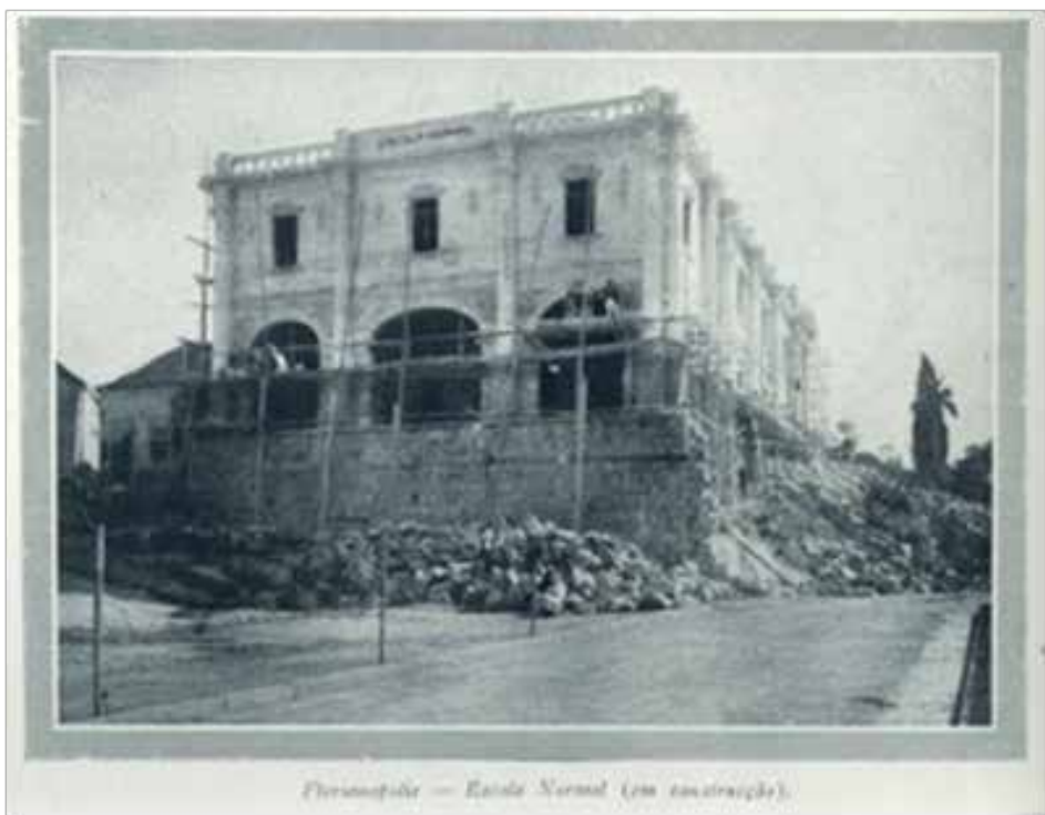
Figura 2. Escola Normal, em construção, c. 1922.
