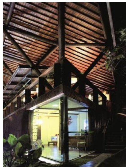
Figura 16: Estrutura do Telhado Fonte: http://www.pousadateju.com.br/ Acesso em 25/03/2015
