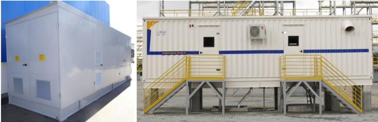
Figura 2.10 – Tipos construtivos de Eletrocentro
