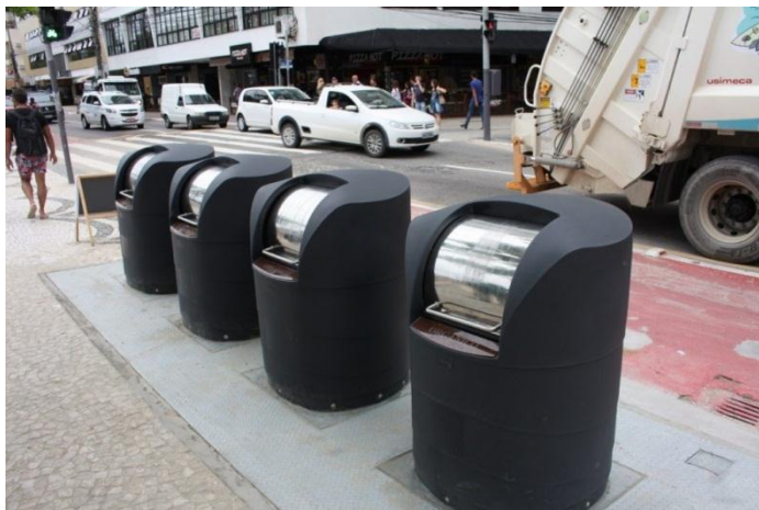
Figura 14 - Sistema de Contentores Subterrâneos
