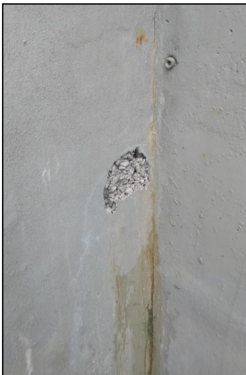
Figura 13 - Vazamento no Sistema BAS.
