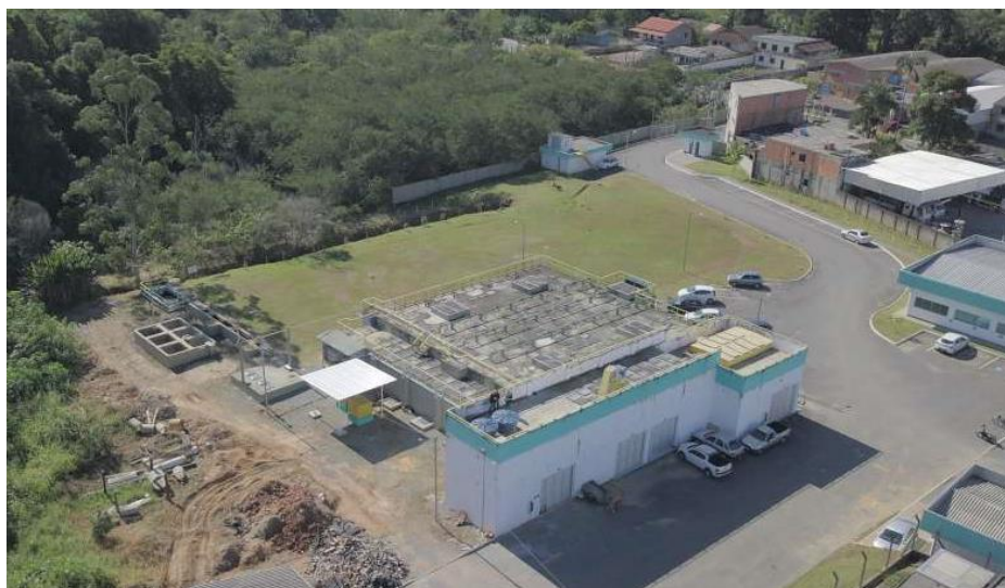
Figura 2 - Estação de Tratamento de Efluentes.
