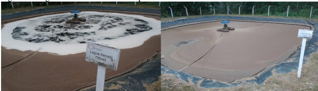
Figura 5 - Lagoa Aerada de mistura completa
