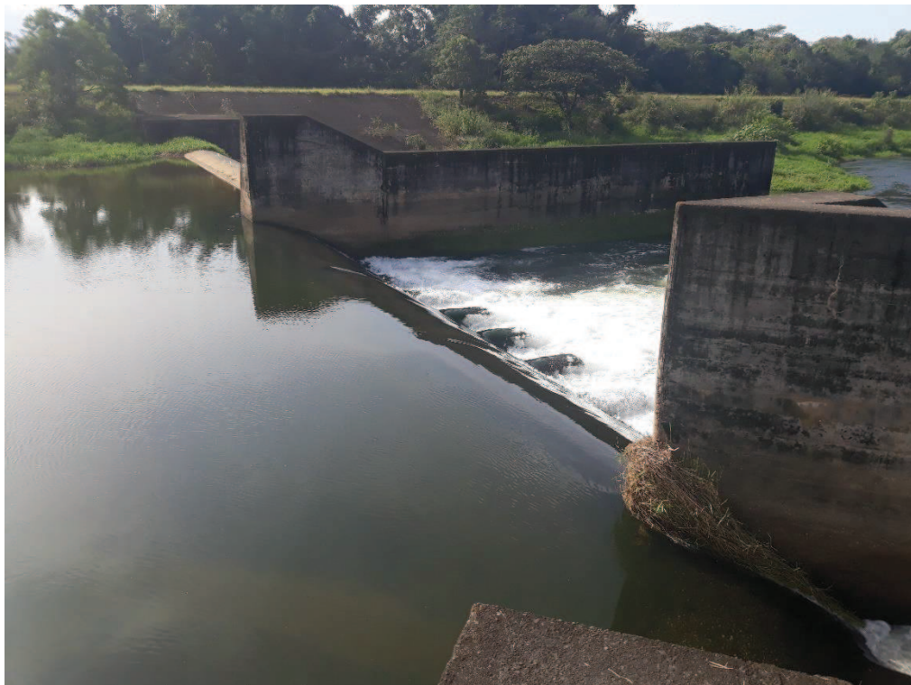
Figura 10– Barragem do Rio Cubatão em Pirabeiraba
