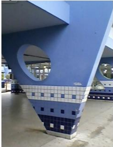
Figura 4 - Pilar vazado em 2013
