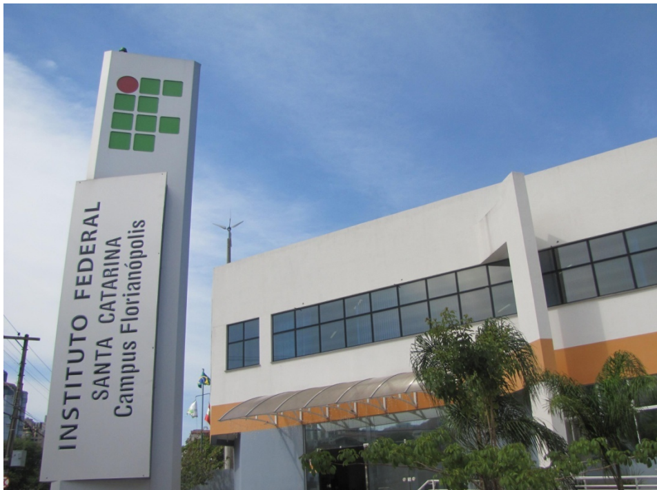
Figura 22 – Fachada do IF/SC - Campus Florianópolis Fonte: http://florianopolis.ifsc.edu.br/
