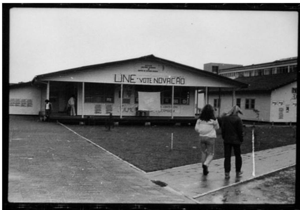
Figura 1 – Instalações do Colégio de Aplicação na década de 1970. Ao fundo a antiga Faculdade Filosofia Ciências e Letras de Santa Catarina.
