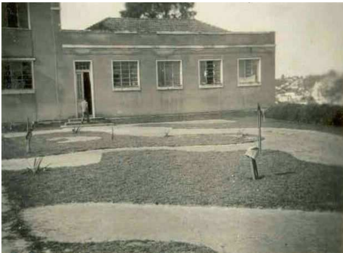
Figura 8 – Prédio do Ginásio Barão de Antonina, vista do Salão Nobre - 1952
