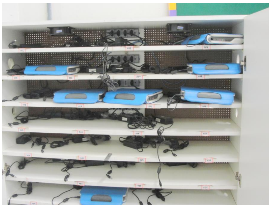
Figura 15: Armário adaptado para o recarregamento de baterias.
