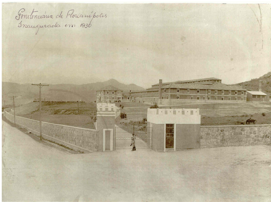
Figura 1 – Estrutura externa da Penitenciária da Pedra Grande.
