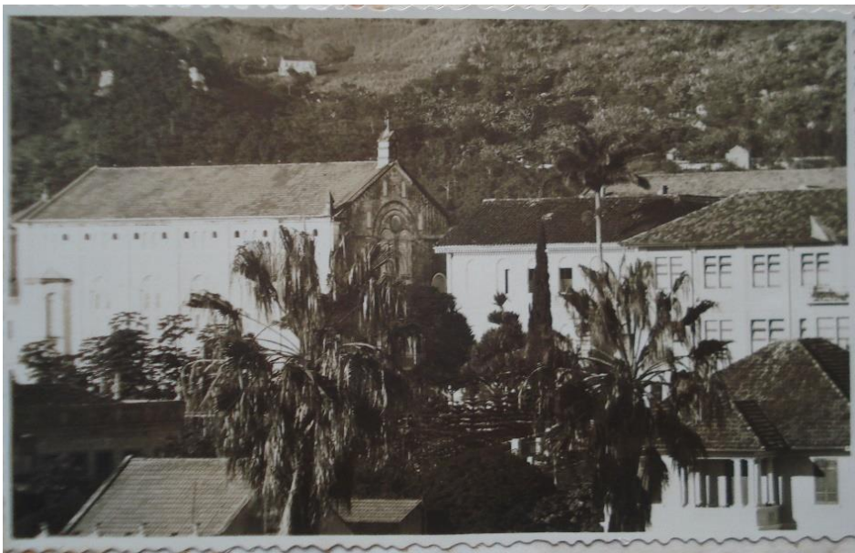
Figura 6 - Fachada do CCJ, 1940/41
