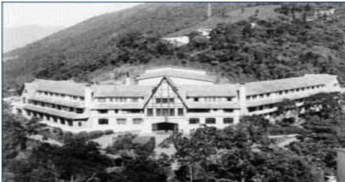
FIGURA 01 – Fachada do Colégio Nova Friburgo
