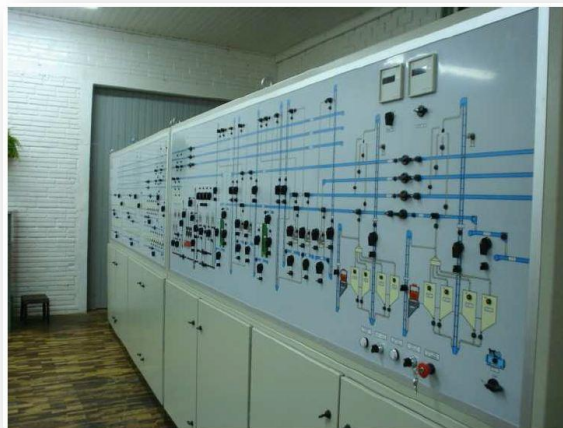
Figura 14 - Exemplo dos primeiros painéis supervisórios
