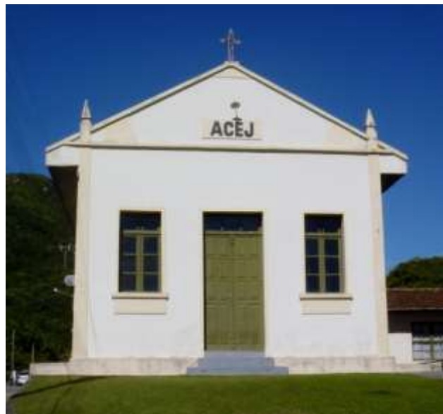
Imagem 10 – Vista parcial do segundo templo da Igreja Presbiteriana do Jordão, construído em 1926, sendo usado pela comunidade até 1998. Em 30/05/2013. Registro fotográfico feito por Matheus Felipe Santiago.
