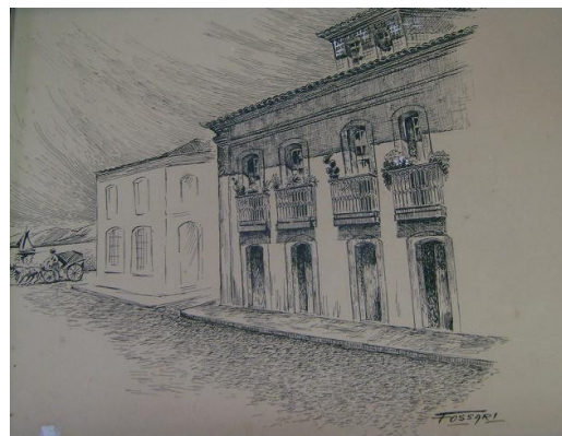
Figura 13 – Fossari. Casa da sotéia. Rua Saldanha Marinho. Já demolida.
