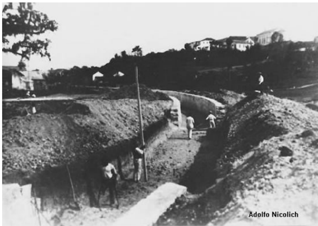
Figura 5 - Obras de canalização do Rio da Bulha, atual Av. Hercílio Luz – 1919 37
