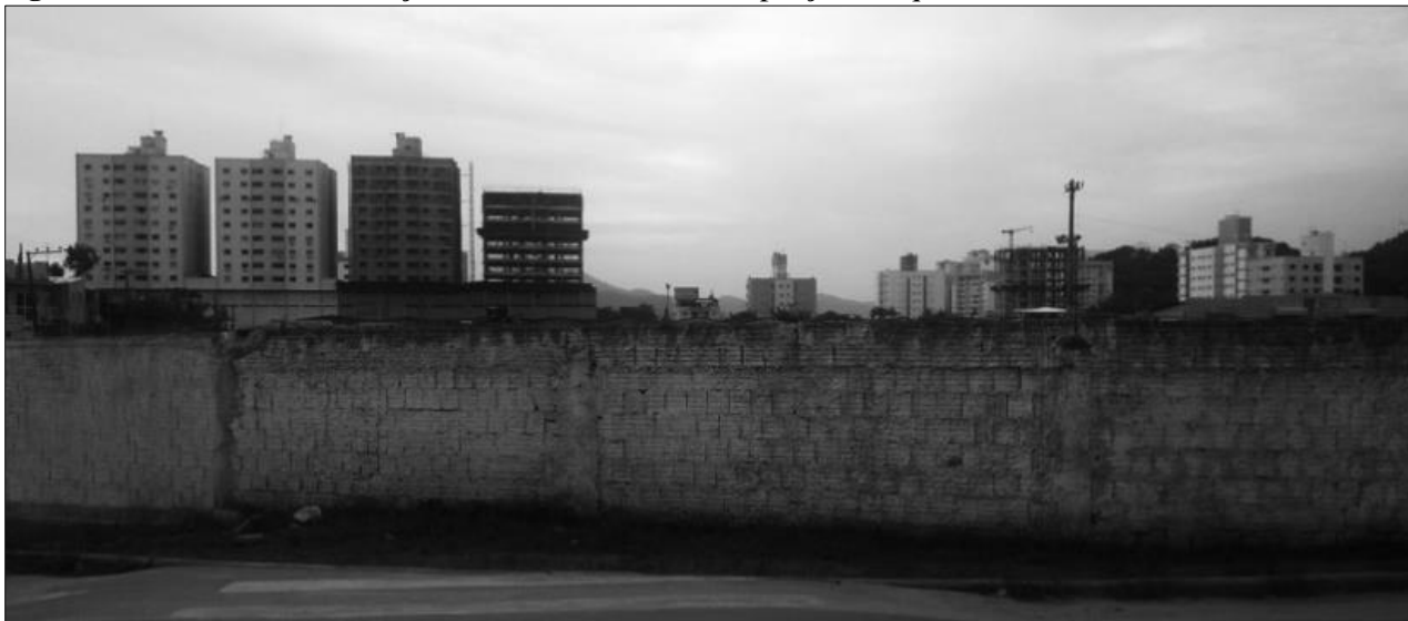
Figura 2 – Prédios em construção no bairro Tabuleiro, na porção em que faz divisa com Balneário Camboriú
