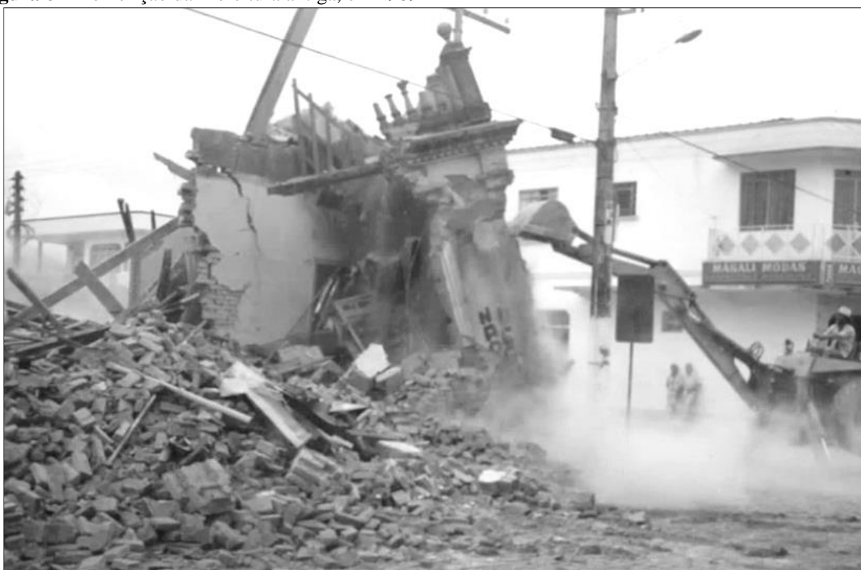
Figura 8 – Demolição da Prefeitura antiga, em 1989
