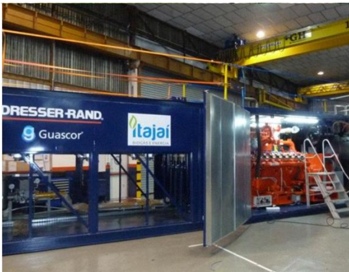
Figura 9 - Usina de biogás proveniente de aterro em Itajaí.
