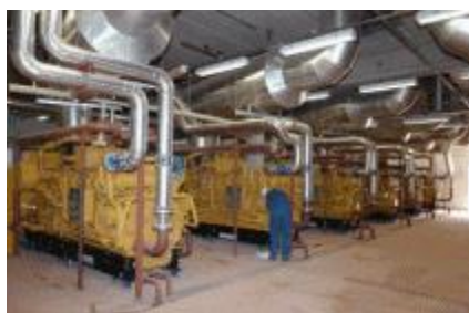
Figura 10 - Casa de máquinas
