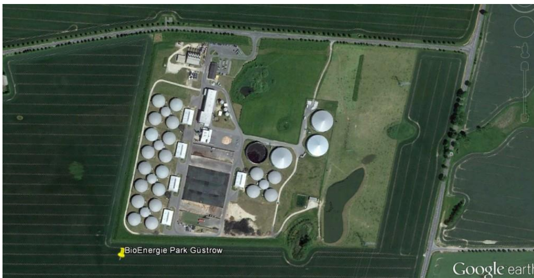
Figura 12 - bioEnergie Park Güstrow, o maior biodigestor do mundo na atualidade.
