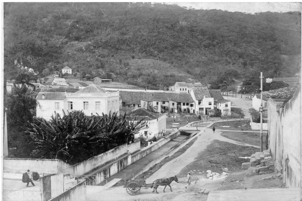
Figura 1 - Rio da Bulha após a canalização (Foto: Acervo IHGSC)
